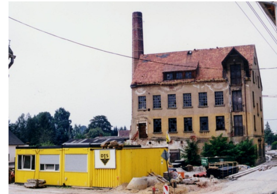
Abbruch/Freifläche Bischofswerdaer Str. 78
