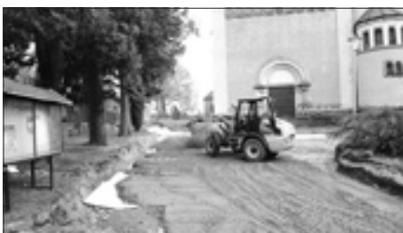
Erneuerung Kirchplatz Bretnig
