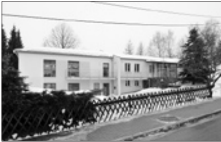
Kindertagesstätte „Zwergenland“ Hauswalde: Fertigstellung des An- und Umbaus
