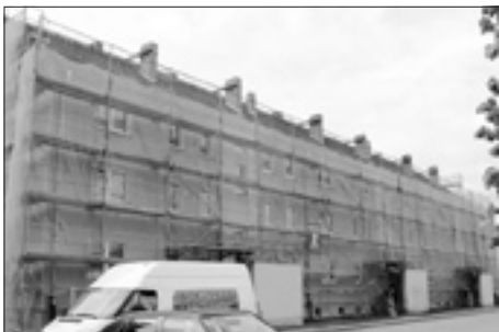
Sanierung Wohnblock Ringstraße 18-22
