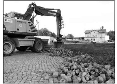
Baustart am P+R-Platz vor dem Bahnhof
