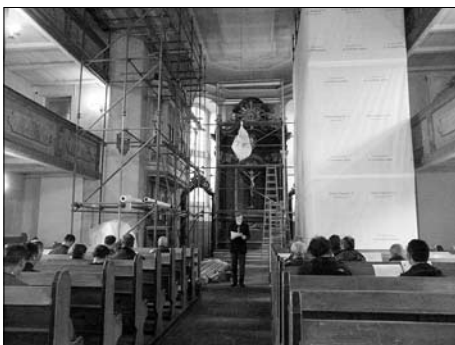
Die Bauarbeiten an der Stadtkirche begannen.
