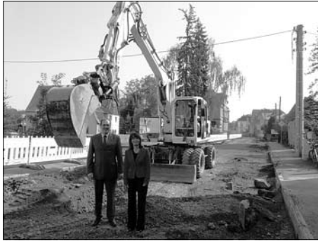
Am 3. September begannen die Bauarbeiten an der Radeberger Straße.
