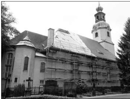
Erster Bauabschnitt bei der Sanierung der Stadtkirche ist abgeschlossen.
