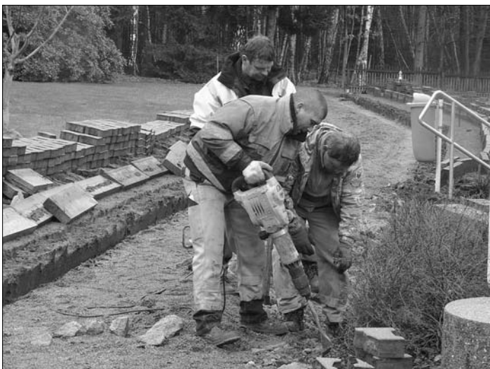
Mitarbeiter des Bauhofes erneuern den Gehweg.
