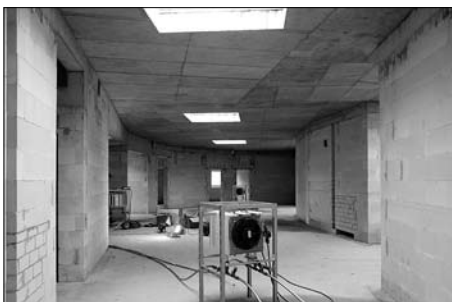
Bauheizung ermöglicht das Arbeiten auch während des Winters.
