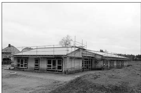
Baufortschritt bei Neubau der Kita Kleinröhrsdorf.
