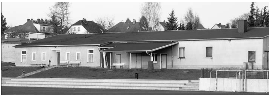
Die Fußballer brachten eine Überdachung am Sportplatzgebäude an.
