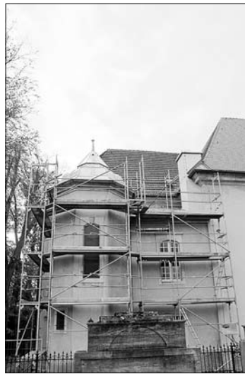
Sanierung der Turmkuppel
