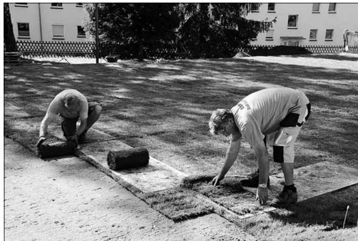
Veit Zeise (links) und Rüdiger Browatzke bei der Verlegung des Rollrasens
