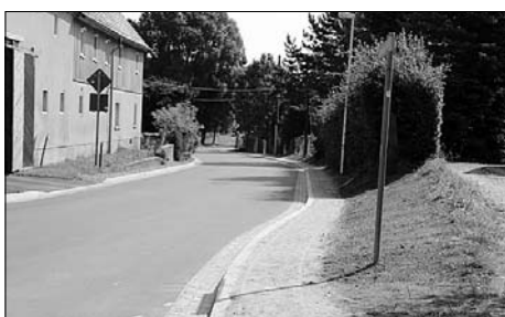
Anfang September kann die Leppersdorfer Straße nach der Beseitigung von Hochwasserschäden wieder für den Verkehr freigegeben werden.
