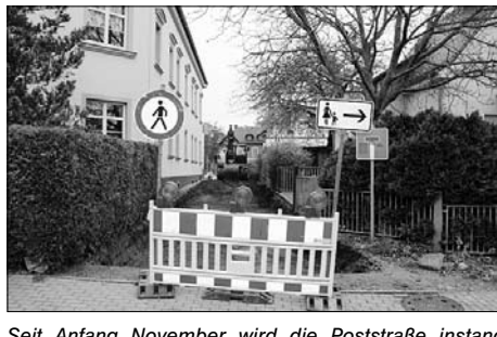
Seit Anfang November wird die Poststraße instand gesetzt.
