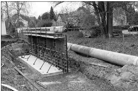
Erneuerung der Stützwände an der Großen Röder in der Niederstadt
