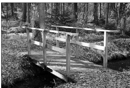
Die Mitarbeiter des Technischen Dienstes errichten zwei neue Brücken im Massenei-Wald.
