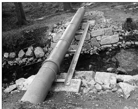
„Böschung an der Brücke Adolf-Zschiedrich-Straße“ und
