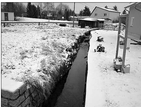
Im Rahmen der Schadensbeseitigung nach dem Hochwasser 2013 konnten die Maßnahmen „Rohrbrücke im Bereich Birkenwäldchen“,
