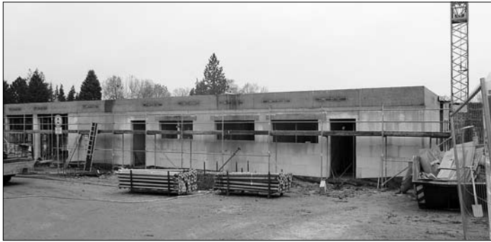
November 2017: Der Rohbau ist fertig.
