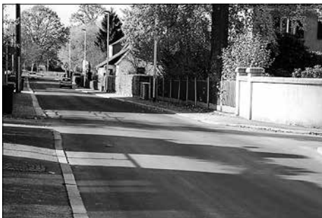
Nach Beendigung der Kanalarbeiten wird die Lutherstraße wieder für den Verkehr freigegeben.
