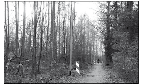
Die Arbeiten an der Beleuchtung des Radweges nach Kleinröhrsdorf beginnen.
