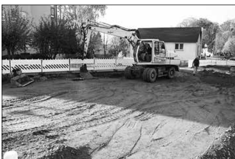
Die Johann-Sebastian-Bachstraße wird an der Einmündung zur Pulsnitzer Straße erneuert.
