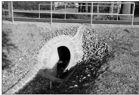
Der Grumbachdurchlass an der Lange Straße wird erneuert.
