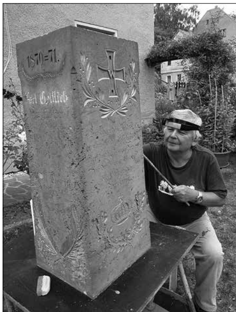
Das Kriegerdenkmal für die Gefallenen in den Jahren 1866 und 1870/71 im Ortsteil Bretnig wird restauriert.
