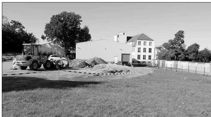
01.09.2020 - Baubeginn für die neue 700 qm große Lagerhalle der SHZ GmbH
