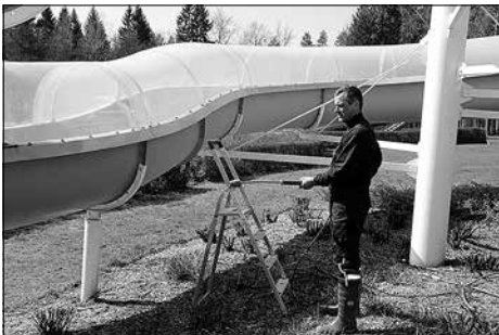
Frühjahrsputz im Massenei-Bad- Vorbereitung auf die Badesaison 2020
