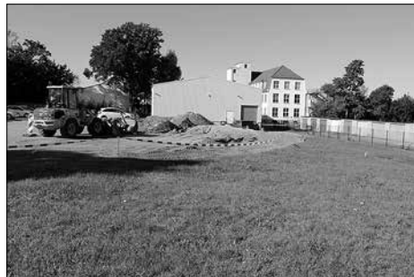
01.09.2020 - Baubeginn für die neue 700 qm große Lagerhalle der SHZ GmbH.
