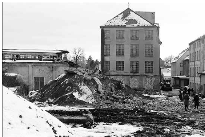
Das Ergebnis der Sprengung – ein Haufen Ziegelsteine.
