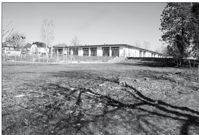
Auf der freien Fläche neben der Schule sollen die neuen Umkleiden entstehen.
