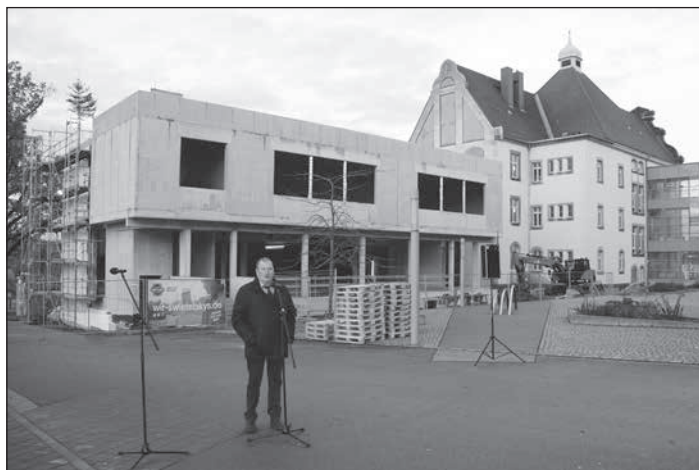
Schulleiter Ulrich Schlögel vor dem Erweiterungsbau
