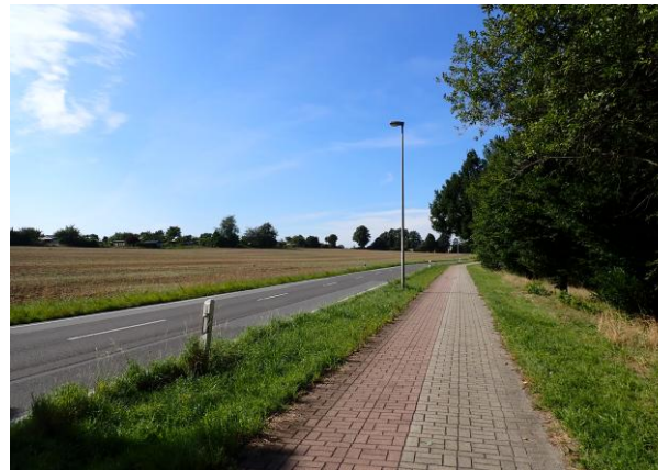
Foto 7: Blick nach Norden entlang der S 56 mit Fuß- und Radweg im Plangebiet
