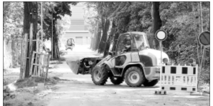
Entlang der Parkstraße entsteht ein Fußweg
