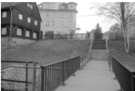
Die Mühlstraße sowie die neue Fußgängerbrücke sind nach längerer Bauzeit endgültig fertig.
