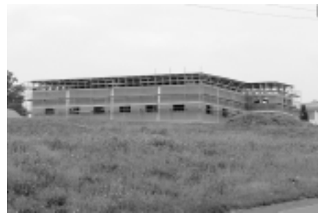
Bereits nach zweimonatiger Bauzeit feiert die inower GmbH Mitte September Richtfest.
