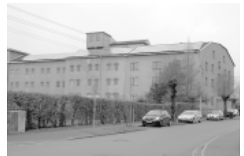
Photovoltaikanlage des Böhmisches Brauhaus geht pünktlich ans Netz.
