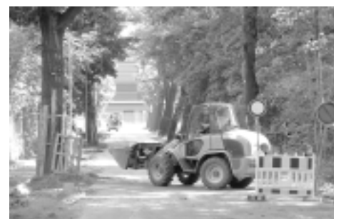
Entlang der Parkstraße entsteht ein Fußweg
