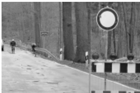
Die Straße zwischen Großröhrsdorf und Radeberg wird für den Brückenneubau gesperrt.
