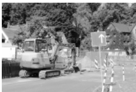
Zahlreiche Kanalerneuerungen in der Stadt
