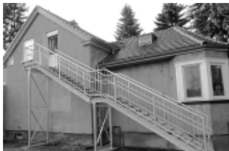
Die Kita in Kleinröhrsdorf erhält zum Abschluss der Umbaumaßnahmen eine Fluchttreppe.
