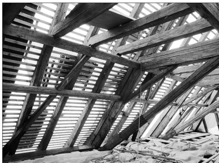
sind durch den Schwamm geschädigt und müssen ausgetauscht sowie angeschuht werden. Ebenfalls war dadurch die Dachkonstruktion über die Jahre ca. 10 cm gesunken. Damit drückte die sich selbst tragende Konstruktion immer mehr auf die Außenmauern. Um das Hängeträgerwerk wieder zu heben und die befallenen Stellen austauschen zu können, war es notwendig, das Dach abzudecken, um den Dachstuhl kurzzeitig von der Schwere der Dachziegel zu entlasten.
