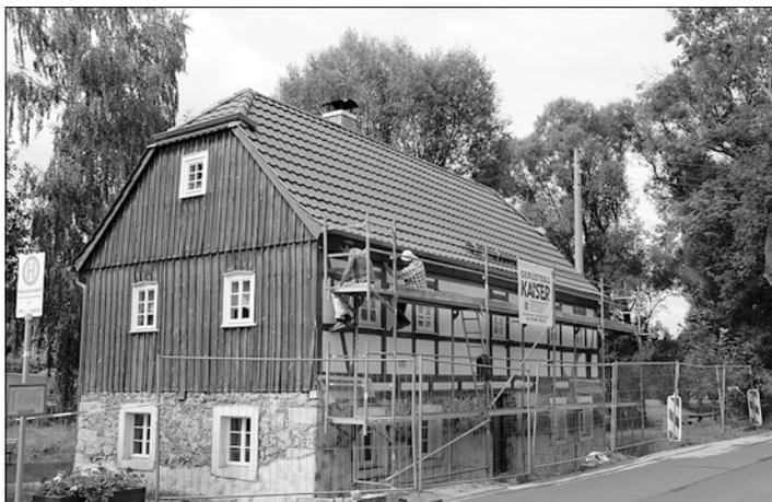
Die Fachwerkfassade zur Straßenseite wird entsprechend den Anforderungen an den Denkmalschutz vorsichtig saniert und teilweise erneuert. Im Innenbereich wird weiterhin die Elektrik erneuert. Der Abschluss dieser Baumaßnahmen beinhaltet die Wiederherstellung der Außenanlagen.
