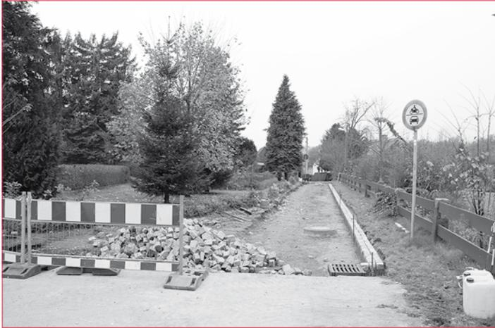
Der Verbindungsweg für Fußgänger zwischen „An der Siedlung“ und der „Rödertalstraße“ in Kleinröhrsdorf wird durch die Technischen Dienste in Zusammenarbeit mit der Fa. Fehre neu gepflastert. Die Arbeiten haben bereits begonnen. Die Fertigstellung ist abhängig von den kommenden Witterungsverhältnissen.
