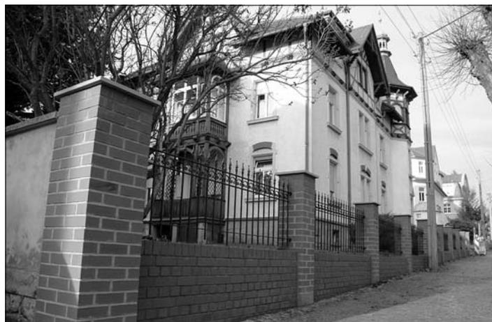
Die alten Säulen waren marode und verfielen zusehends. Alle Säulen erhielten eine Abdeckplatte aus Sandstein. Der schmiedeeiserne Zaun, speziell das Schmuckband im oberen Drittel der Zaunfelder, wurde den hölzernen Schmuckelementen in der Fassade vom Gebäude angepasst und fügt sich nun besser in die Gesamterscheinung des Gebäudes ein. Ein Durchgang für Fußgänger sowie ein zweiflügeliges Tor ermöglichen die Zufahrt zum Gebäude über die Poststraße.
