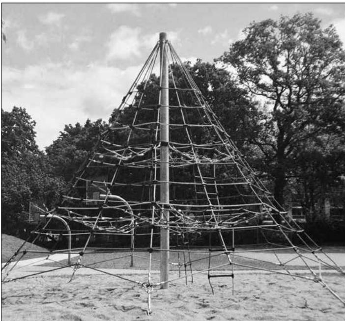
Dafür hat der Technische Dienst bereits neun Fundamente im hinteren Bereich des Bades neben dem Planschbecken für die kleinsten Badegäste in die Erde eingebracht. Das 4,50 Meter hohe Klettergerüst besteht aus einem Hauptpfosten, vom dem aus das Kletternetz in den umliegenden Fundamenten verspannt wird. Pünktlich zum Start in die Badesaison im Mai soll die Kletterpyramide fertig sein.
