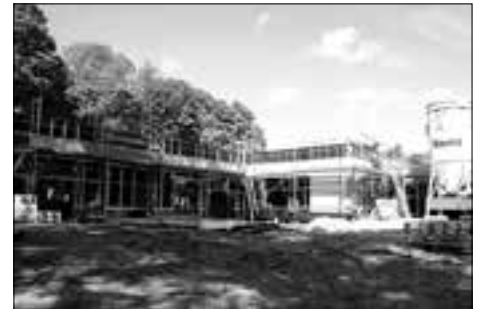
Die AWO Lausitz lud in der ersten Maiwoche zum Rohbaufest für die neue Kita „Bummiland“ ein.
